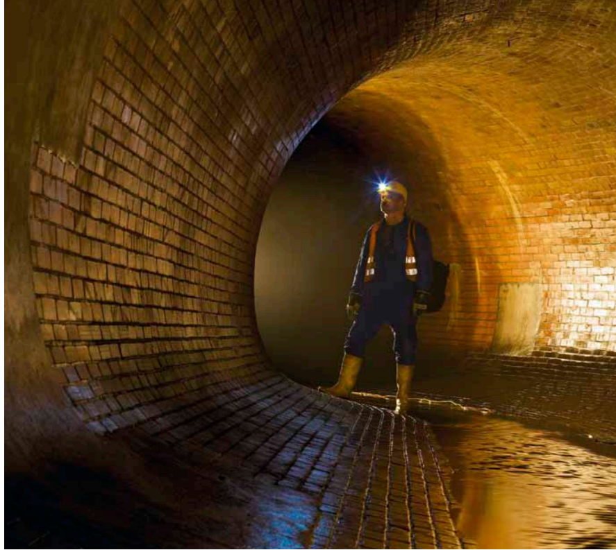
Ein letzter Blick: Mitarbeiter begutachtet einen gereinigten Kanal.
