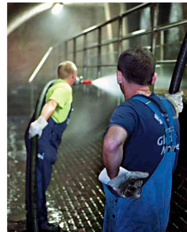
Kanalreinigung mit Hochdruckspülung (Bild links oben). Der zusammengesobte Dreck wird mit Spezialfahrzeugen abgesaugt (Bilder Mitte und links unten). An manchen Stellen wird auch noch von Hand gespült (Bild rechts unten).
