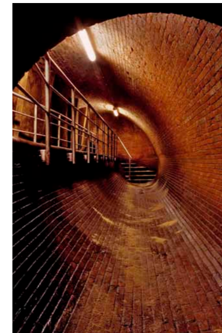
Überlauf des Kanals, 2009
