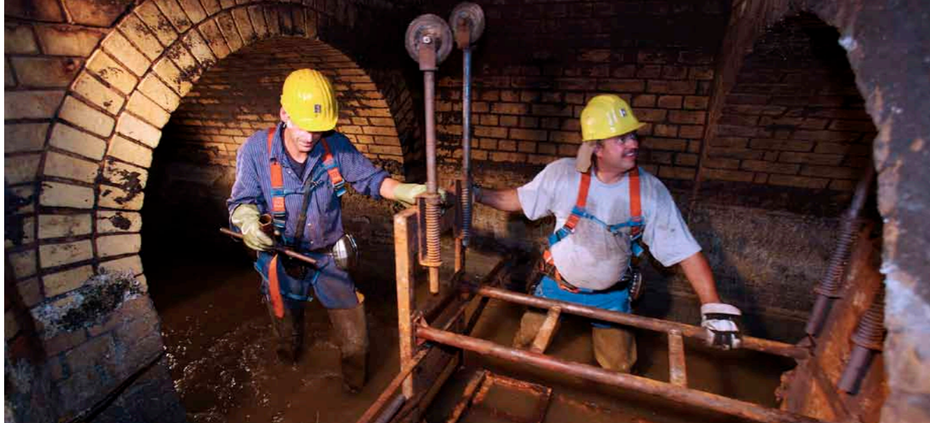
In den wenigen richtig großen Kanälen geht es auch heute noch nicht ganz ohne Handarbeit. Hier bewegen Mitarbeiter ein Schiebeschild zum nächsten Schacht, wo der zusammengesobene Dreck abgesaugt wird.
