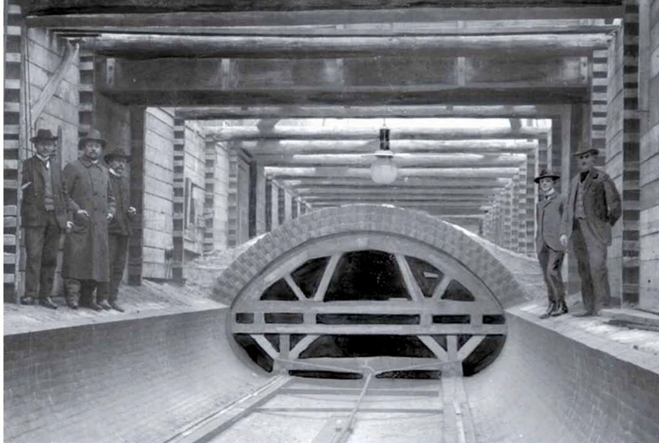
Bau des Kanals an der Hohenstaufenstraße mit Hilfe eines Gerüstwagens, 1904
