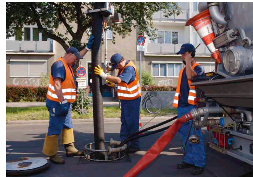
Kanalreinigung mit Hochdruckspülung (Bild links oben). Der zusammengesobte Dreck wird mit Spezialfahrzeugen abgesaugt (Bilder Mitte und links unten). An manchen Stellen wird auch noch von Hand gespült (Bild rechts unten).
